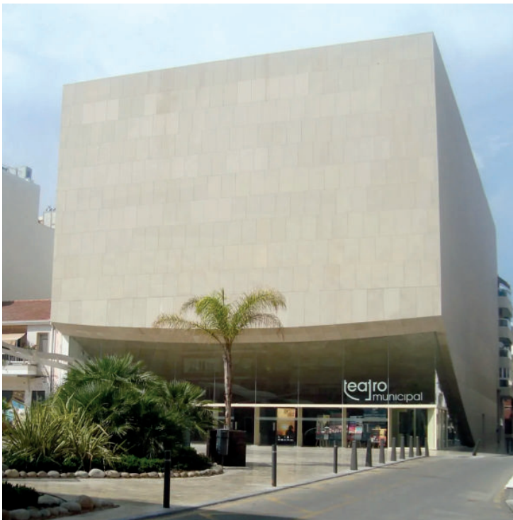
REVESTIMIENTO EXTERIOR E INTERIOR DEL NUEVO TEATRO MUNICIPAL EN TORREVIEJA, ESPAÑA
